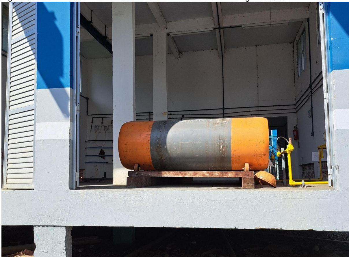
Figura 23: ETA Rio do Sul - sala de armazenamento e cilindro de cloro gás - 03/2025
