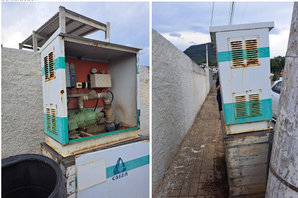
Figura 38: Booster 56 - Abrigo metálico danificado e base inclinada devido a recalque do solo - em 25/03/2025.
