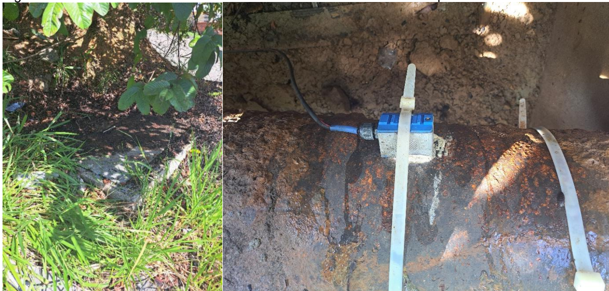
Figura 26: Macromedidor ultrassônico da adutora do R0 instalado na via pública.
