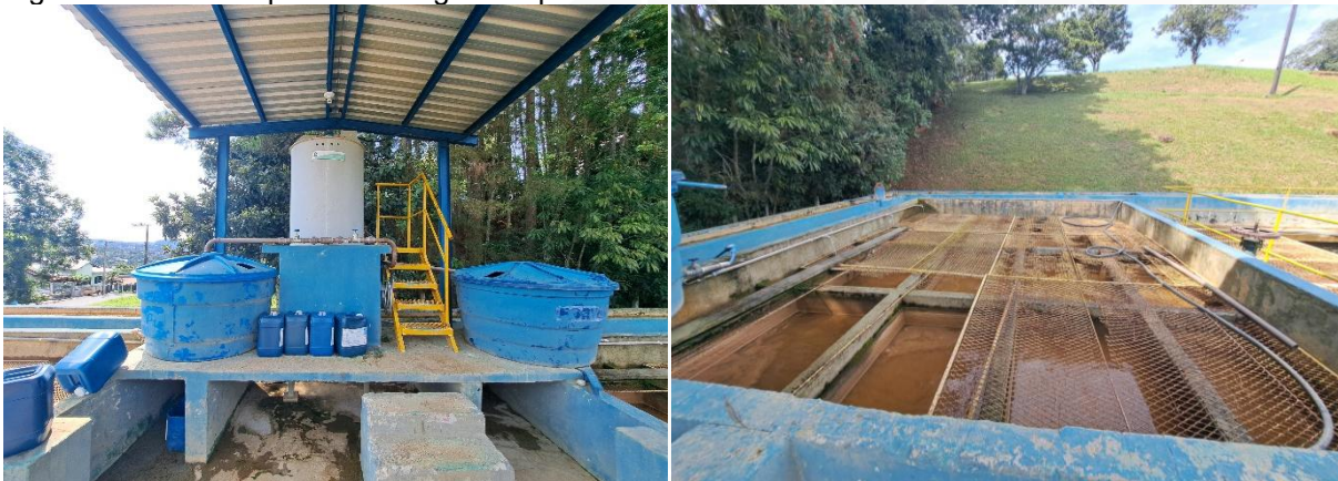
Figura 18: ETA: tanques de dosagem de polímero e flocladores – ETA de concreto armado – 03/2025.
