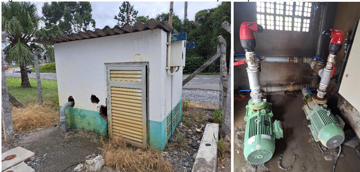
Figura 36: Booster 6 - Estrutura em mau estado de conservação e limpeza - em 26/03/2025.
