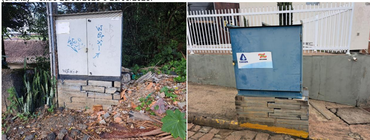
Figura 39: Problemas nas bases construídas com blocos de rocha - Booster 9 (esquerda) e booster 75 (direita) – entre 25/03/2025 e 26/03/2025.
