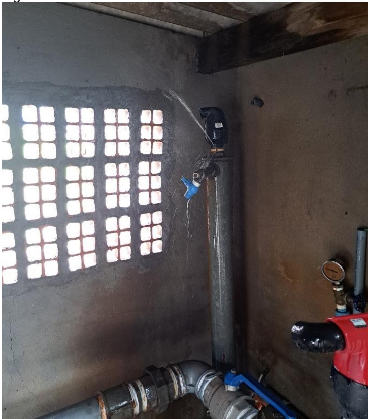
Figura 41: Vazamentos no booster 6 - em 25/03/2025.
