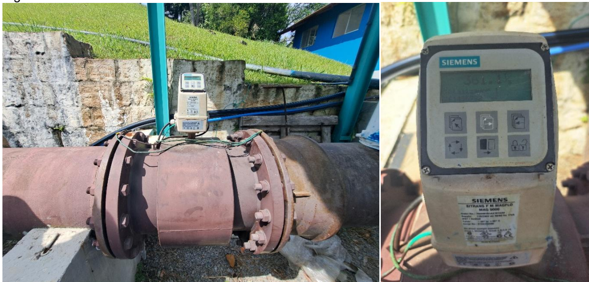
Figura 13: ETA RIO DO SUL - Macromedidor de entrada – 03/2025.
