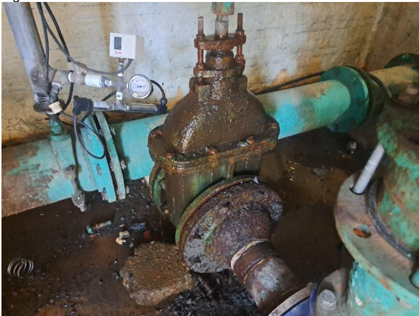
Figura 40: Vazamento em válvula do booster 14 – em 26/03/2025.
