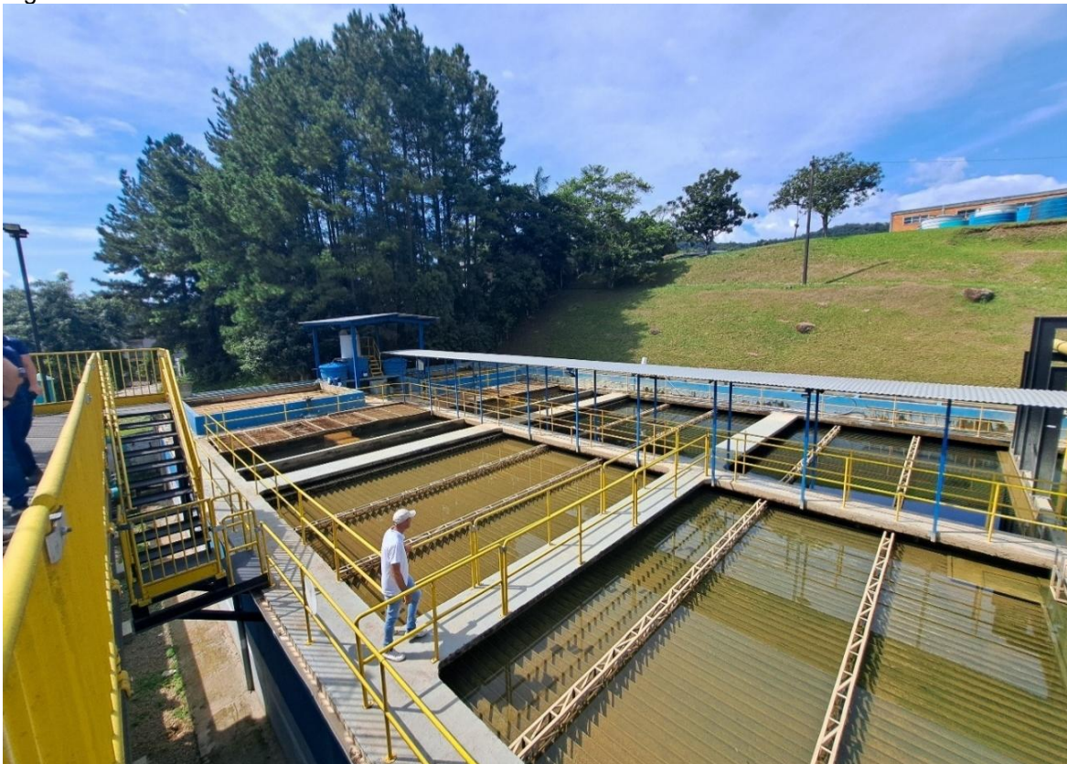
Figura 20: ETA Rio do Sul - decantadores – 03/2025.
