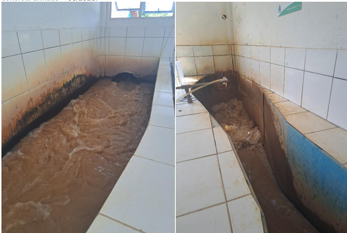
Figura 16: ETA Rio do Sul - Canal de entrada – Calha Parshall e dosagem de coagulante - ETA de concreto armado – 03/2025.
