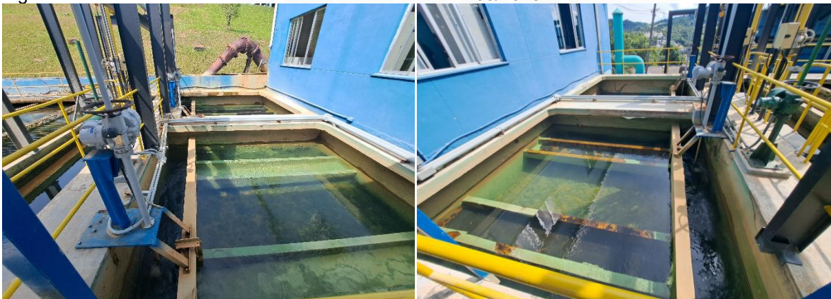
Figura 21: ETA Rio do Sul - filtros e módulo de concreto - 03/2025.
