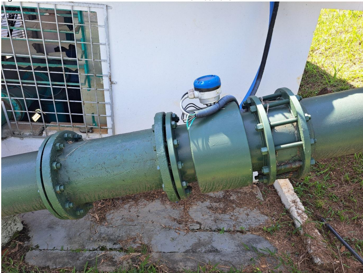
Figura 24: ETA Rio do Sul - macromedidor da ERAT 3 – 03/2025.
