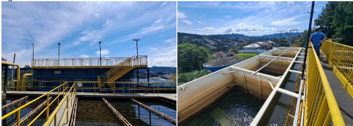
Figura 22: ETA Rio do Sul - filtros e módulo metálico – 03/2025.
