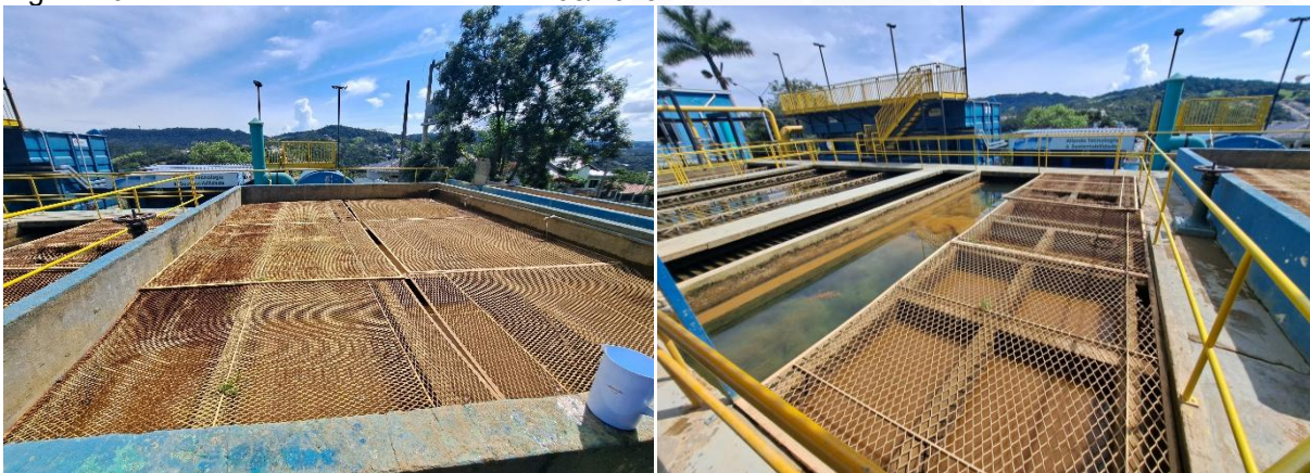
Figura 19: ETA Rio do Sul - flocladores – 03/2025.
