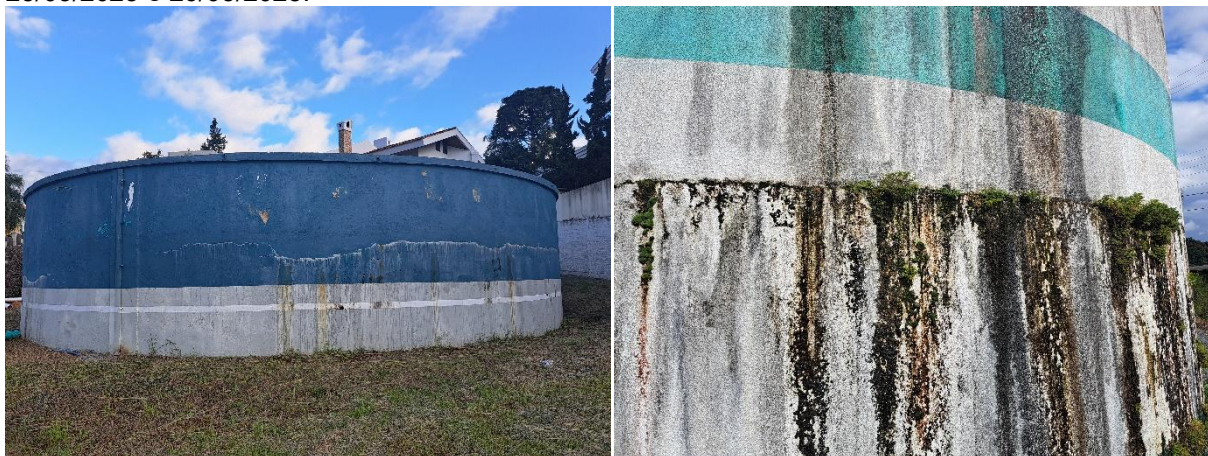
Figura 33: Reservatórios R1 (esquerda) e R12 (direita) em mau estado de conservação – entre 25/03/2025 e 26/03/2025.
