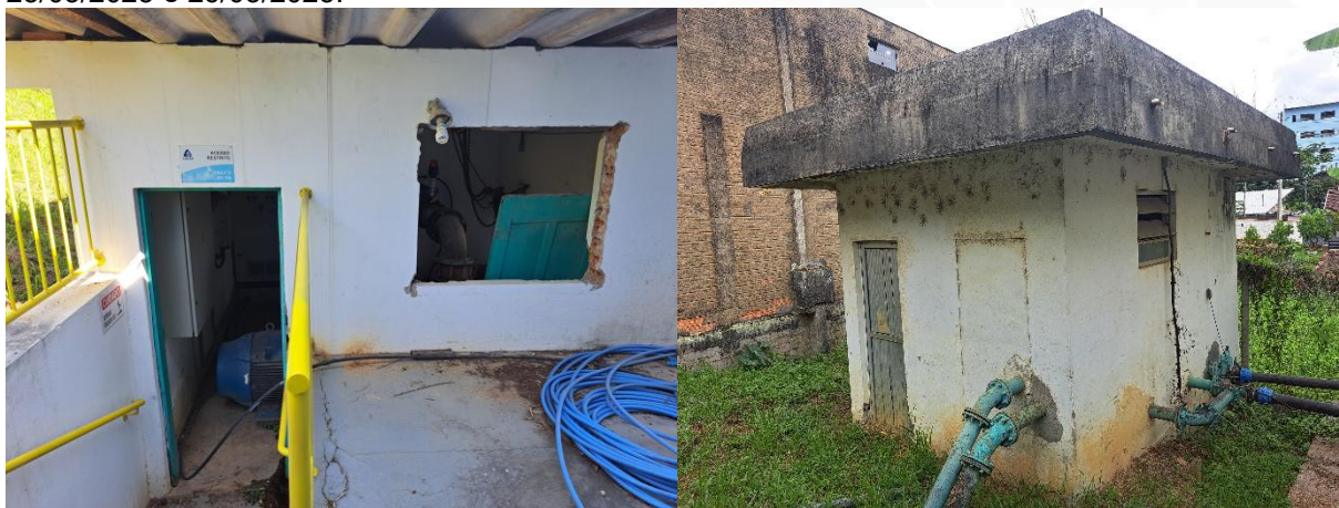
Figura 37: Má conservação das unidades de recalque – ERAT 03 (esquerda) e ERAT 16 (direita) entre 25/03/2025 e 26/03/2025.
