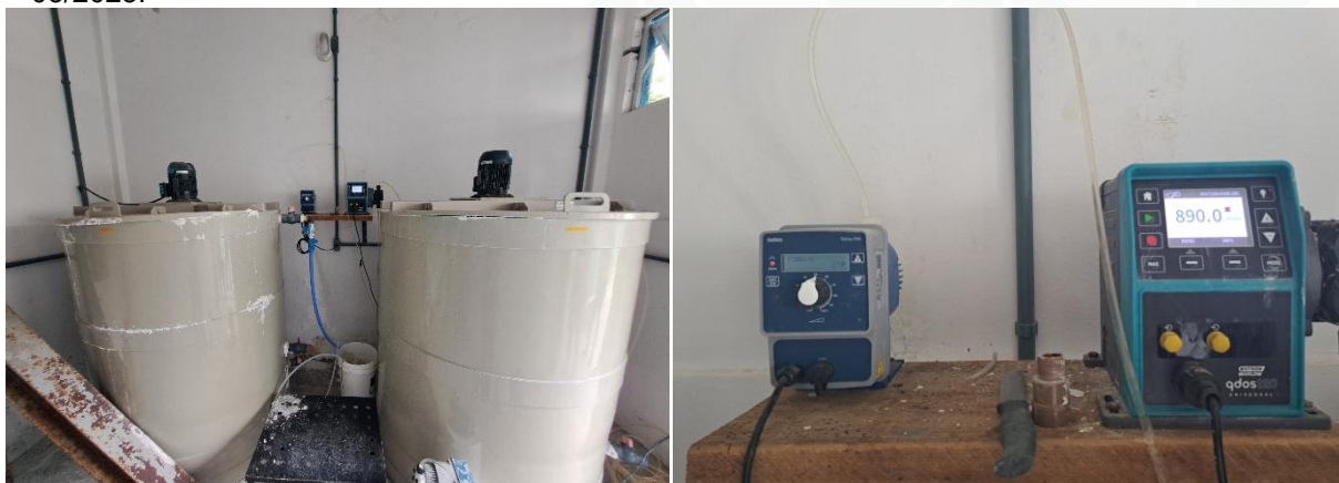
Figura 17: ETA – correção de pH - tanques de preparo e bombas dosadoras – ETA de concreto armado – 03/2025.
