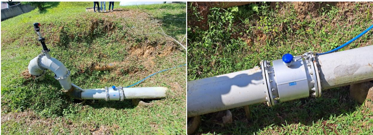
Figura 25: ETA Rio do Sul - macromedidor da Adutora R0 – 03/2025.
